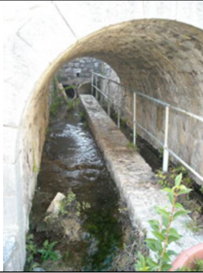
Photos 8 : vue vers l'amont de l'ouvrage sous la RD .907
