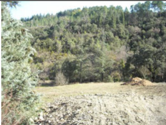
Photo 59 : lit majeur du Graviès avec zone naturelle en rive droite et champ en terrasses en rive gauche
