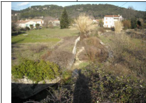
Photo 73 : Vue du mur de soutènement en aval de la voie ferrée (mur effondrée en 2002 en rive gauche)
