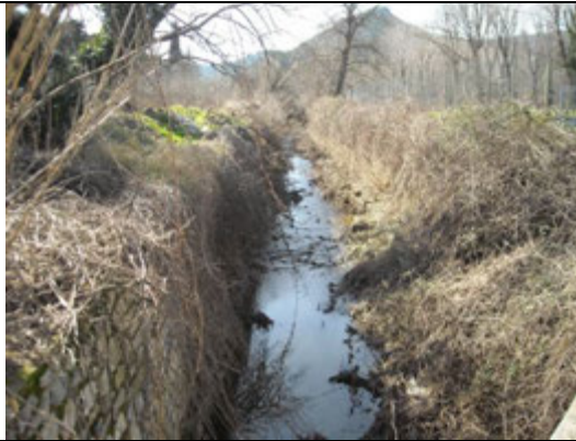
Photo 4 : Vue vers l'amont du lit emmurée depuis le pont du chemin de Recoulin (Castel Rose)
