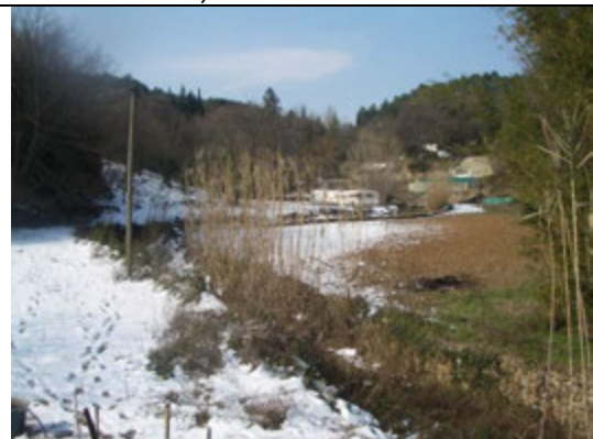
Photo 84 : vue des murs de soutènement vers l'amont en direction du camping de Veyrac
