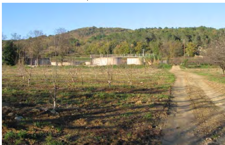
Station d'épuration en zone inondable
