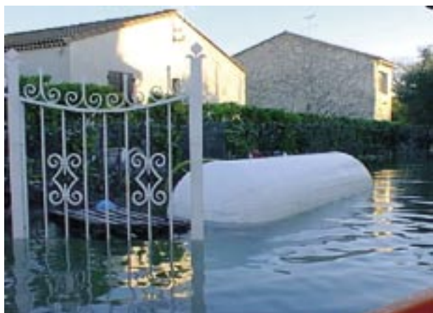
Cuve soulevée par l'eau.
