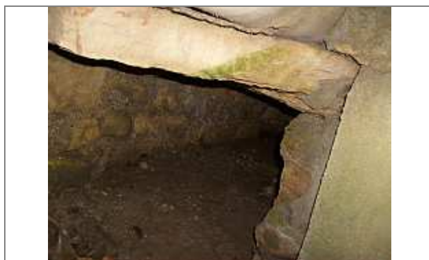
Photo 10 : Départ galerie maçonnée - regard NIM005, route de Montpellier
