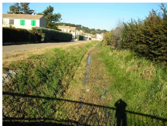
Photo 22 : La Pondre vue amont prise depuis la rue des Muriers
