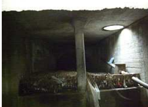
Photo 5 : Vue aval du dégrilleur – regard TEM025, place du Temple
