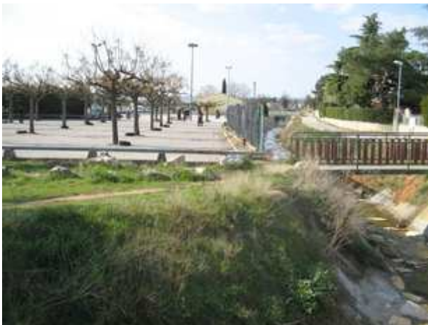
photo 2 : travaux après la crue 2005
