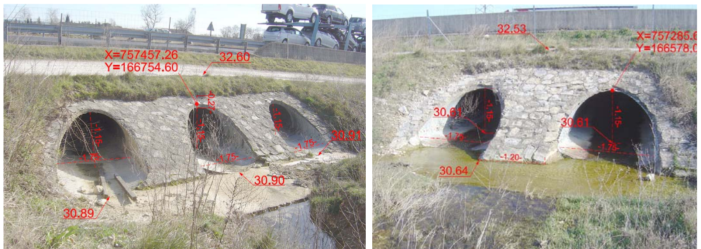
Figure 17 : 2 Ouvrages de franchissement de l'A9 hors OH 24 (Bernis).
