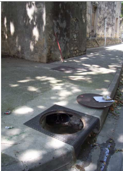
Photo 10 : Exutoire du réseau pluvial situé à proximité du temple
