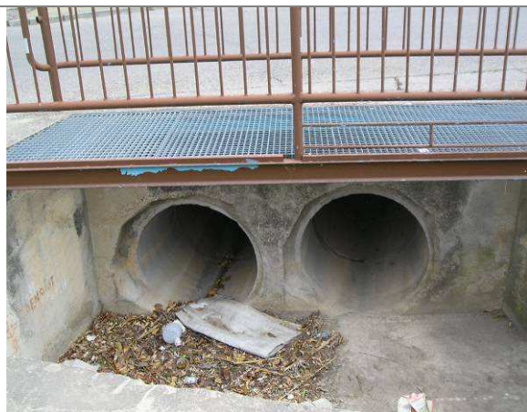
Photo 4 : Ouvrage de récupération des eaux de surface
