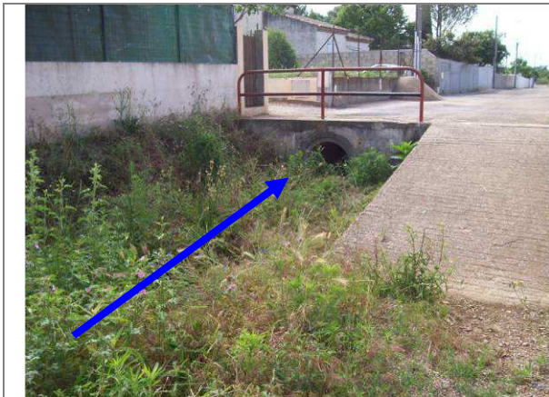
Photo 1 : Amont rue de la Vallongue - départ conduite Ø 800 mm
