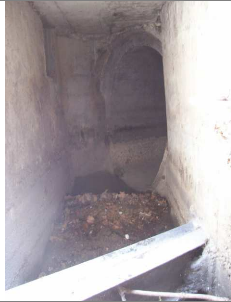
Photo 15 : Vue sur l'ovoïde - canalisations transversales
