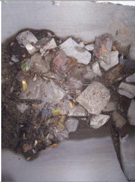
Photo 14 : Vue sur l'ovoïde - dépôts
