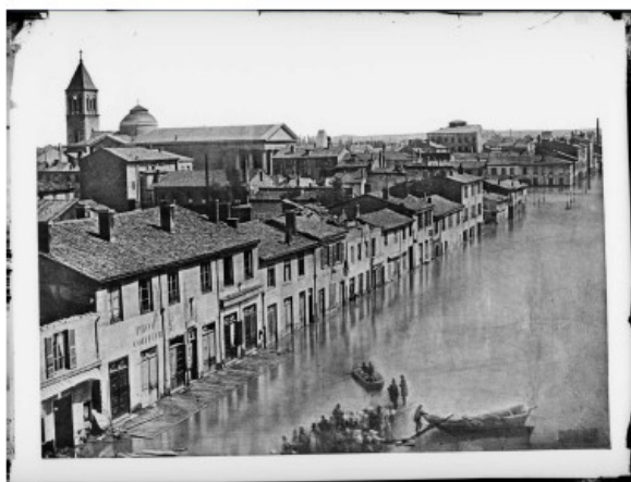
Inondation du Rhône, à Lyon : avenue de Saxe ; l'église Saint-Pothin en arrière-plan, vers juin 1856 : contretypage d'une épreuve / d'après un cliché Louis Froissart – Archives municipales de Lyon
