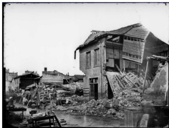
Inondation du Rhône, à Lyon : dégâts : rue Madame (actuellement rue P. Corneille), 9 juin 1856 / cliché Louis Froissart] – Archives municipales de Lyon
