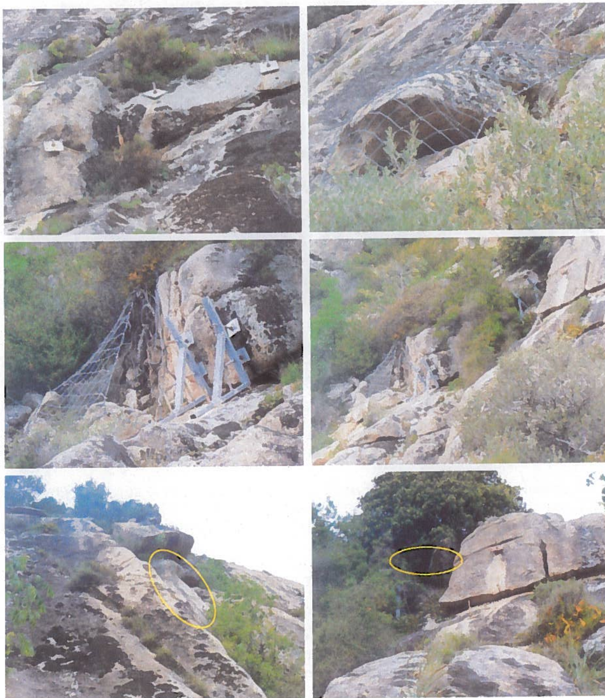
Figure 12: Confortements en amont des habitations
