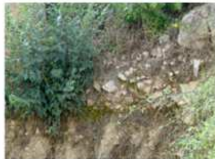
Éboulis reposant sur une granodiorite altérée
