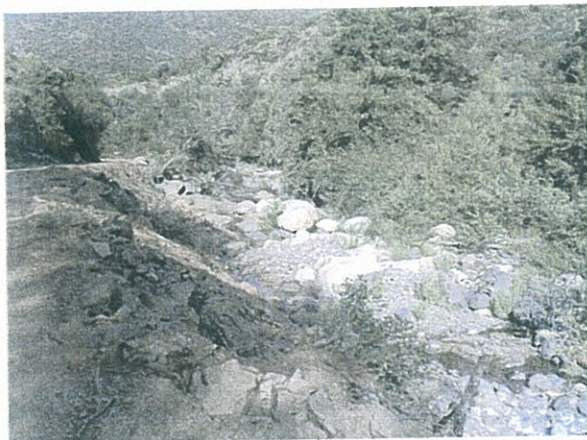
Fortes traces d'érosion le long de la berge en rive gauche, à hauteur de la maison Cassard
