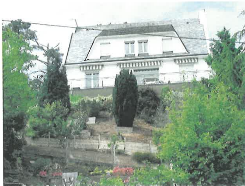
Exemple d'aménagements sur Tréboul
