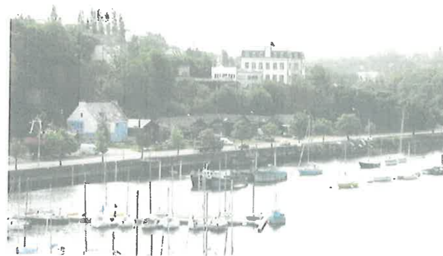
Zone remblayée dans une anse de la rivière de Port Rhu
