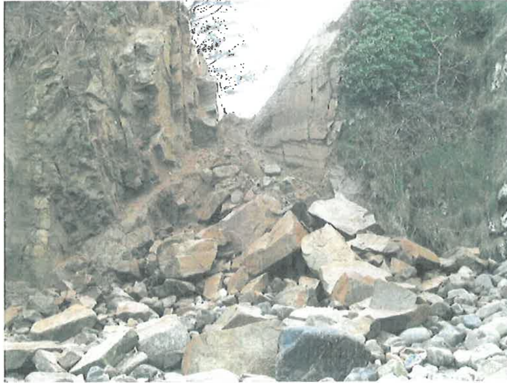
Eboulement aux Sables Blancs
