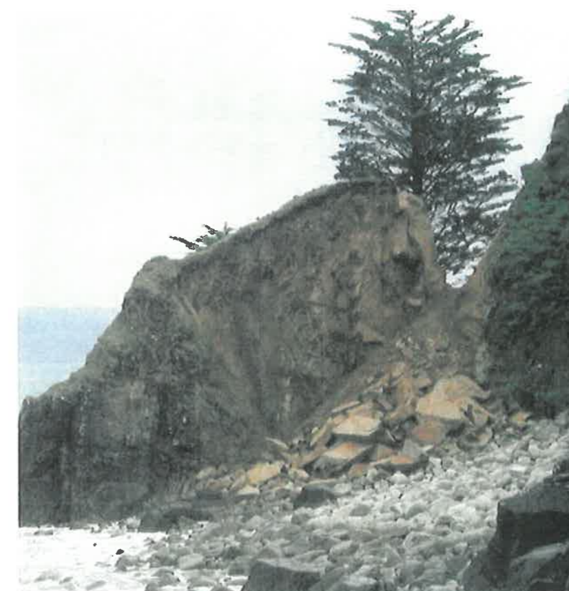
Exemple de désordre dans des formations isotropes mais très fracturées (Eboulement à l'ouest de la plage des Sables Blancs)
