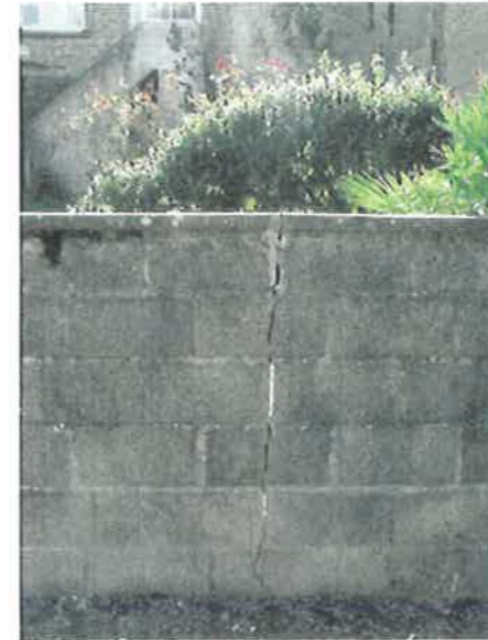
Exemple de désordres à Pouldavid : Fissure sur l'annexe d'un bâtiment
