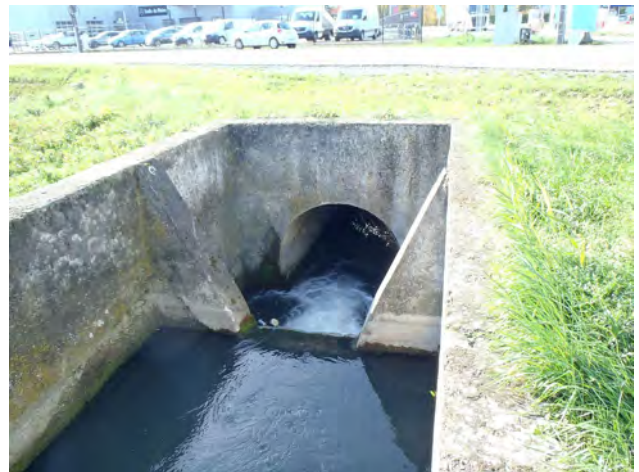
Ouvrage limitant dans la ZA du Meyrol
