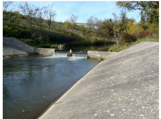
Contre canal digue CNR à l'amont du siphon
