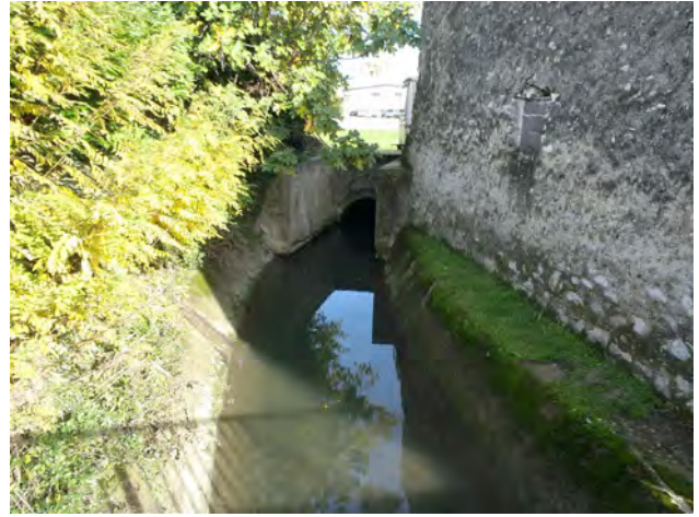
Sortie de la partie enterrée sous l'aérodrome
