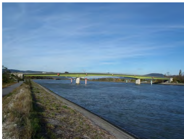
Le canal CNR d'amenée franchit par la RD 11
