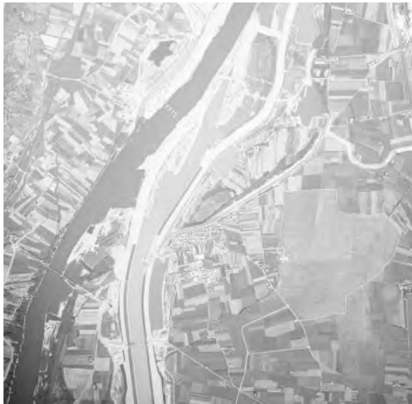
Mission aérienne mai 1957 (source Géoportail) Le tracé du Meyrol sous l'aérodrome est remplacé par le busage
