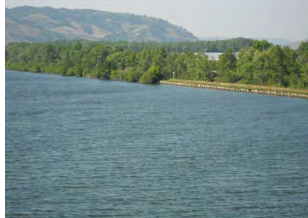
Digue CNR du canal d'aménée et du Rhône (source : DDT26)
