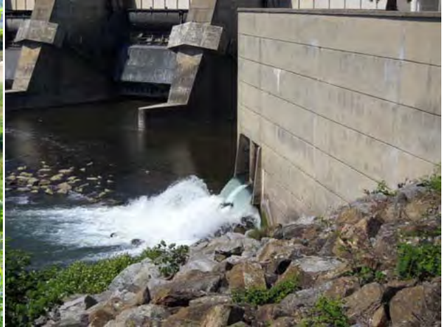
Exutoire du bassin des Musards à l'aval du barrage (source : DDT26)
