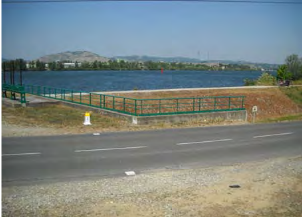
Déversoir de la digue submersible en amont de Chabalet (source : DDT26)
