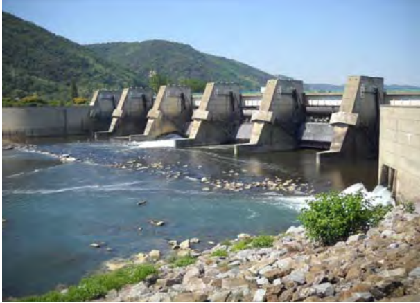
Barrage de La Roche de Glun (source : DDT26)
