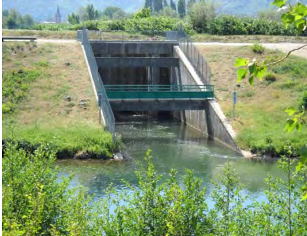
Entrée siphon du contre-canal au bassin des Musards (source : DDT26)
