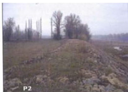
Digue de Chatelas – zone enrochée (photo Prolog)
