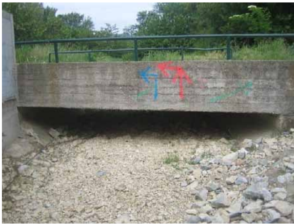
Ouvrage très limitant avant exutoire dans le contre canal du Rhône
