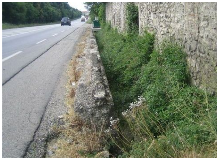
Ruisseau des Fées à l'aval du franchissement de la RN7
