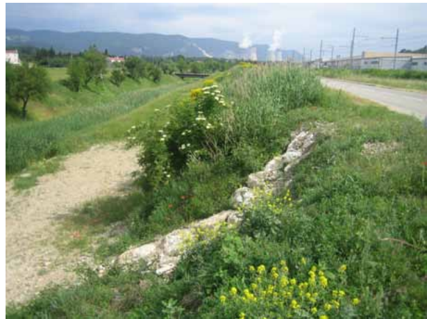
Canal CNR réparé après la crue de août 2008
