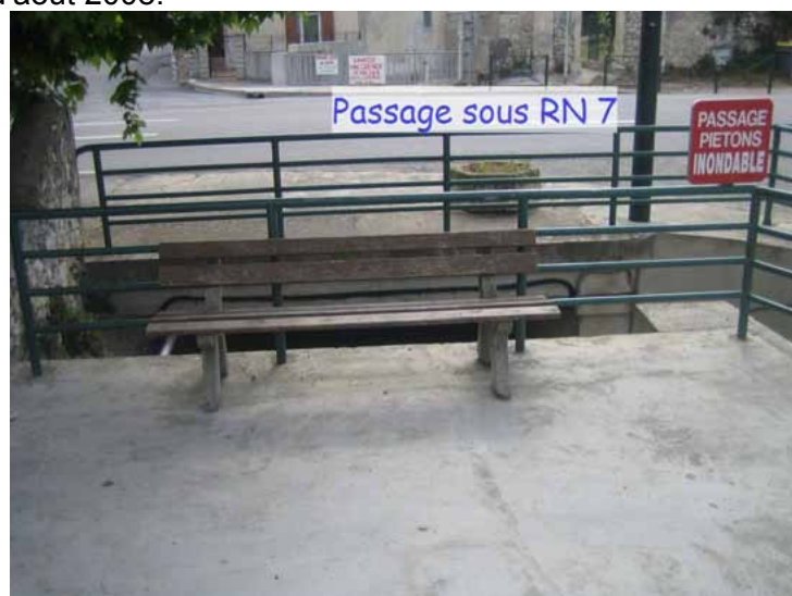
L'Armagna passage sous la RN 7
