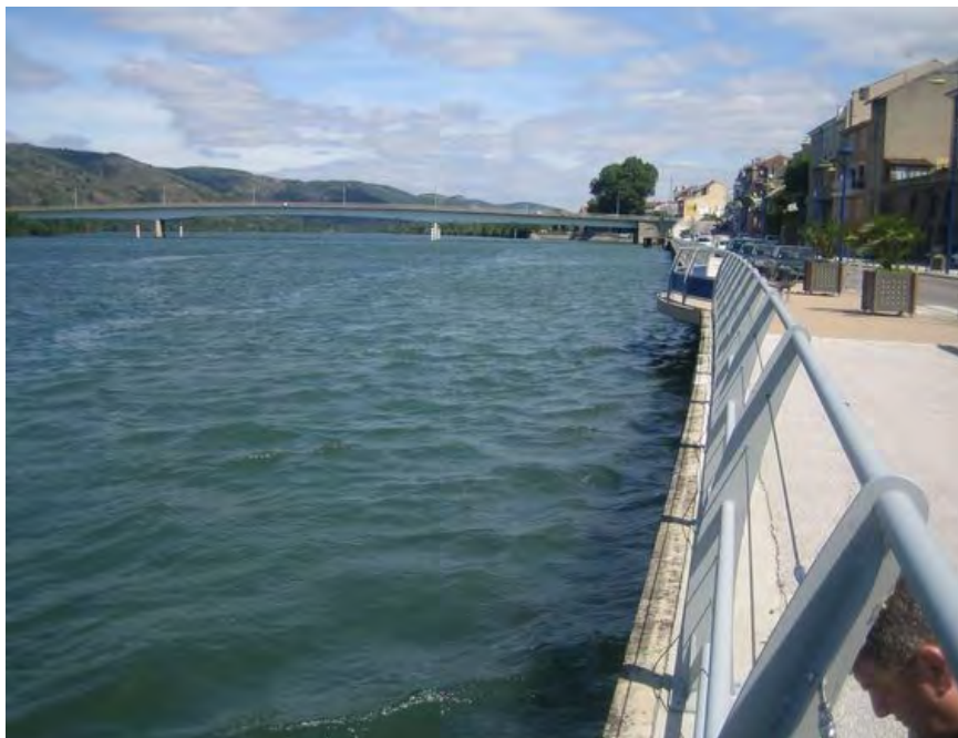
Le « quai » de Saint-Vallier et le pont vers Sarras en Ardèche (photo : DDT26)
