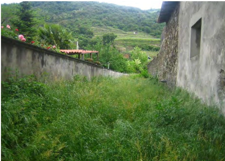
Digues du ruisseau des Barres en amont de la N7 (source : DDT26)
