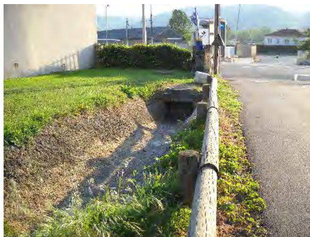
Franchissement de la RN7 par le ruisseau des Marais et des Coffins (source : DDT26)
