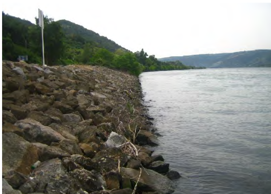
La digue CNR au Nord de Serves-sur-Rhône (source : DDT26)
