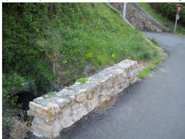
Franchissement de la voie SNCF par les ruisseaux des Marais et des Coffins (source : DDT26)
