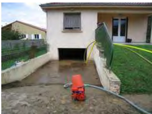
Garage inondé en bordure de la RD 630
