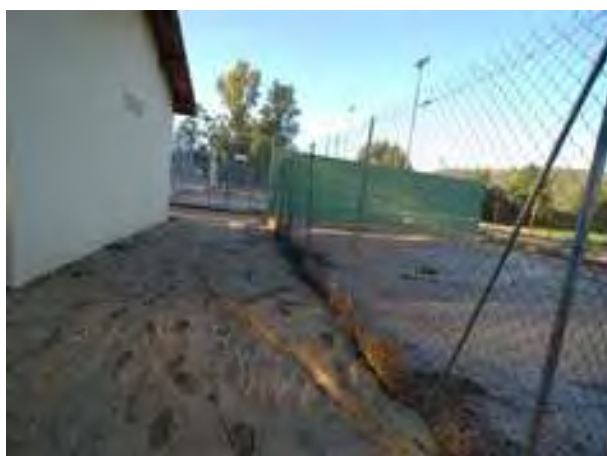
Dépôt de limons sur les terrains de tennis
