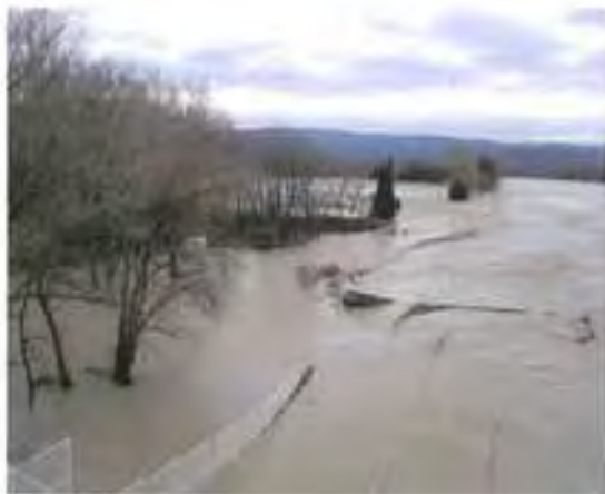
Décembre 2003 – aval barrage de Donzère (photo DDE)
