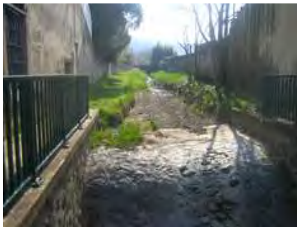
Le seuil au franchissement de la RN7
