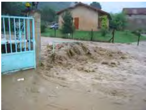
La Rionne en crue sur la RD 630
