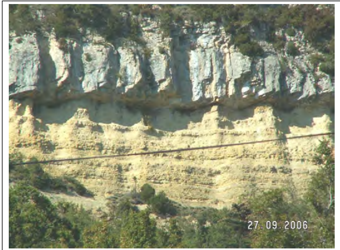
Figure 16a : Falaise du secteur du « Moulin de la Pipe » montrant qu'à ce niveau les bancs calcaires de la base du rocher du Vellan forment souvent des surplombs suite au ravinement des séries de marnes sableuses bleues (du Gargaso-Albien) sus-jacentes.
