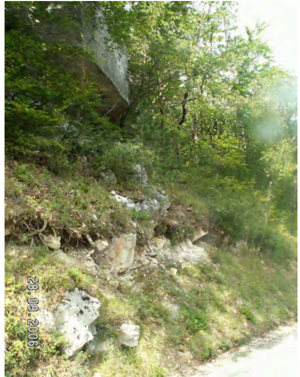
Eboulis de pente non consolidés constitués par un enchevêtrement de gros blocs voir des pans de falaise entiers éboulés, emballés dans une matrice limoneuse à argileuse plus ou peu abondante.
