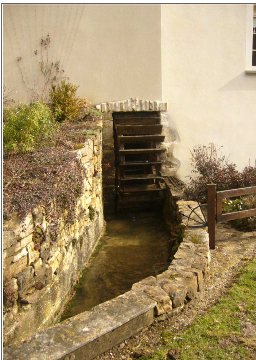
Un moulin sur le bief qui surplombe le village de Ladoye.
