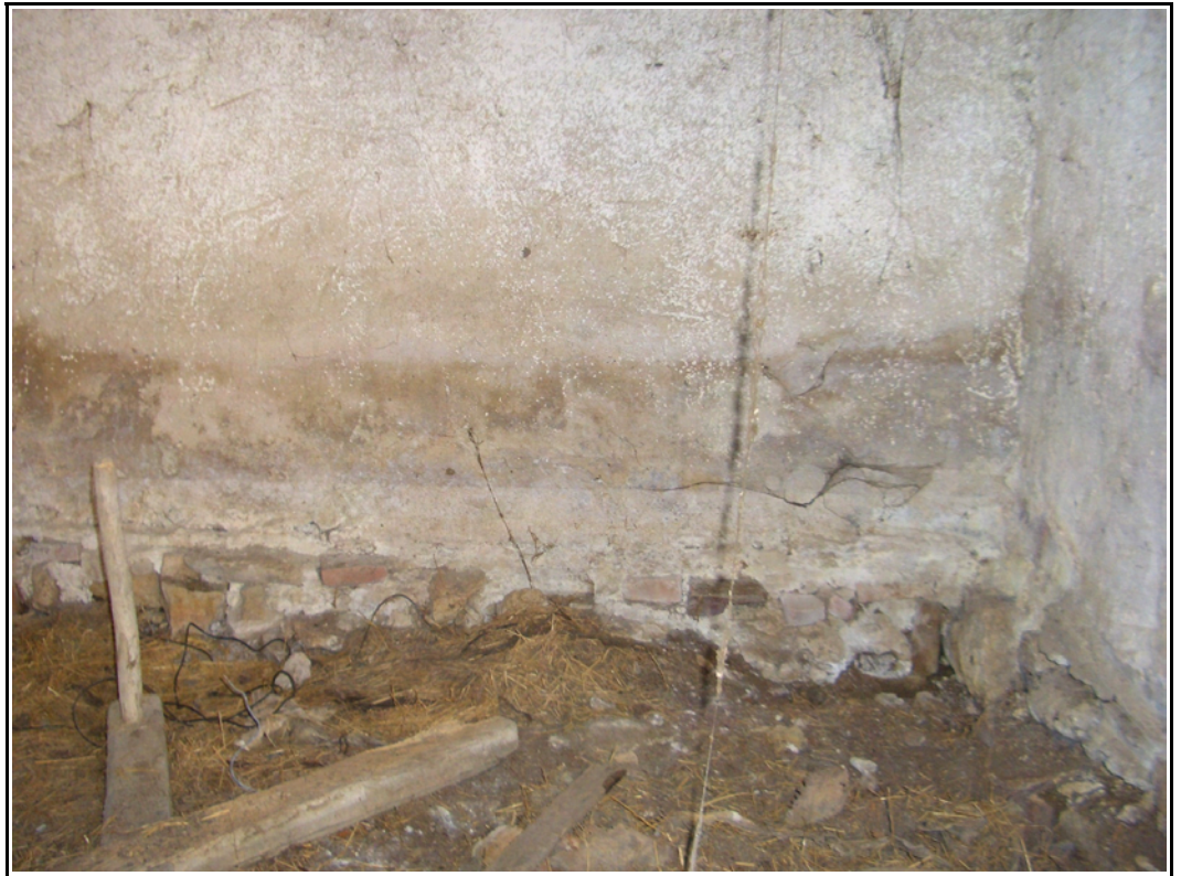
Laisse de la crue de janvier – février 1910 rue Saint Martin (niveau sombre supérieur) ; cette laisse de crue était autrefois matérialisée à l'extérieur de la petite construction par un trait à la peinture, avec une date, mais a été effacé depuis.
