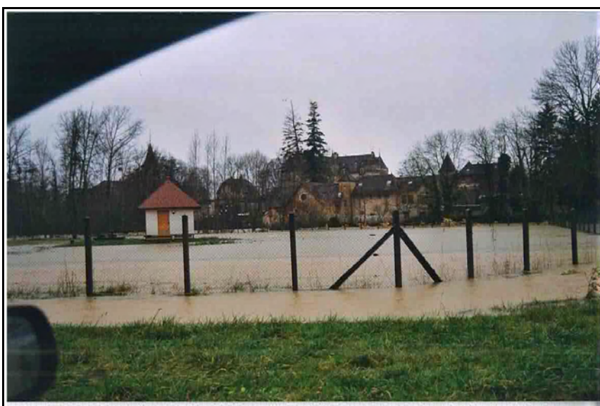
Secteur de la station de pompage des eaux potables, sous le Château de Domblans, novembre 2002 – source mairie de Domblans 2008
