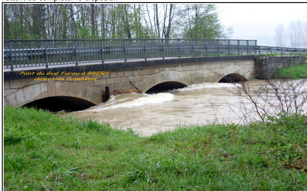
Le pont du Gué Faroux, sous la RD n°193, entre Bréry et Domblans, 17 avril 2005 – source M. Médigue 2009
