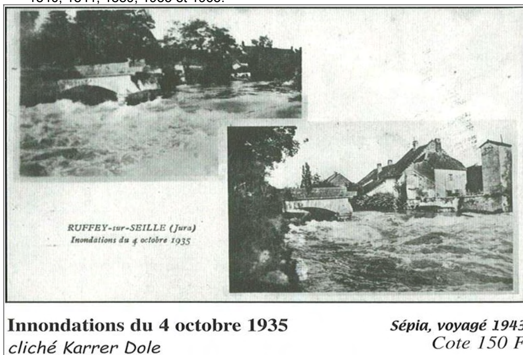
la rupture du pont Neuf de Ruffey sur Seille source M. Romand, collection personnelle
