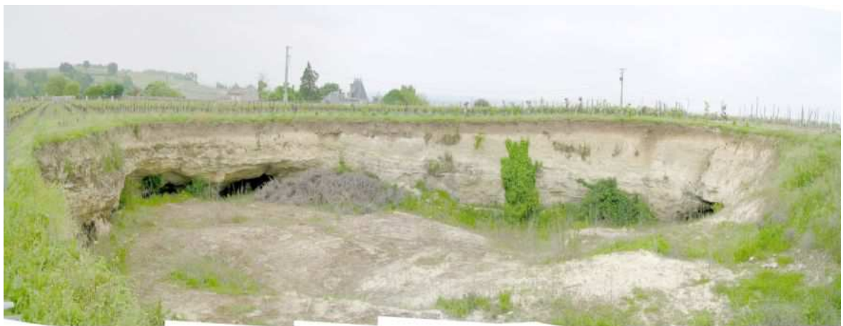
Exemple (Antéagroup) d'aléa effondrement généralisé
