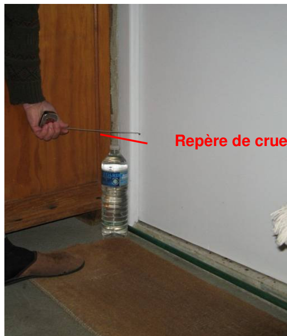
Photo 2 : repère de crue chez un riverain du cours d'eau à Agonac
