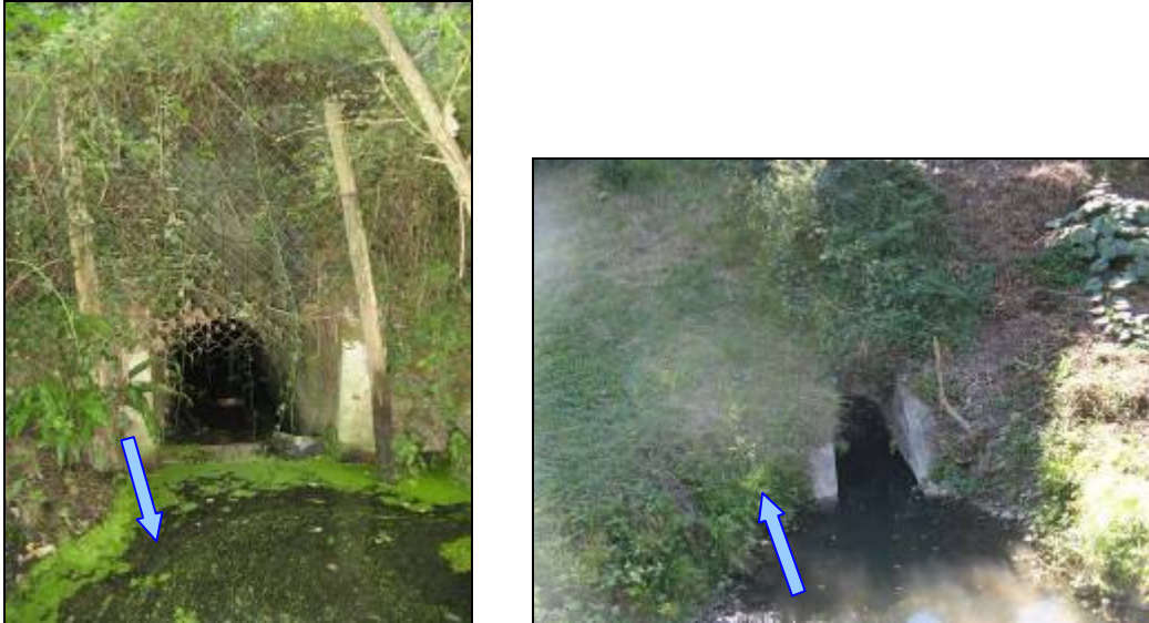
Photos: Ouvrages de franchissement à l'entrée et à la sortie du bras de décharge – Vue du côté du bras de décharge.
