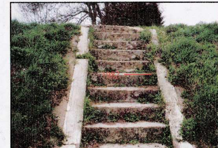
Crue de 1982 au niveau du barrage de Poncey-les-Athée
