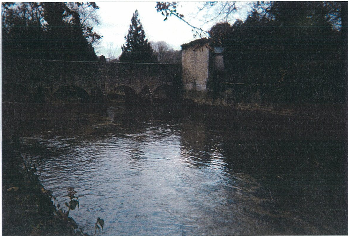
Ph.8: PONT DES BOULANGERS VUE VERS L'AVAL LA SEINE BRAS RIVE GAUCHE
