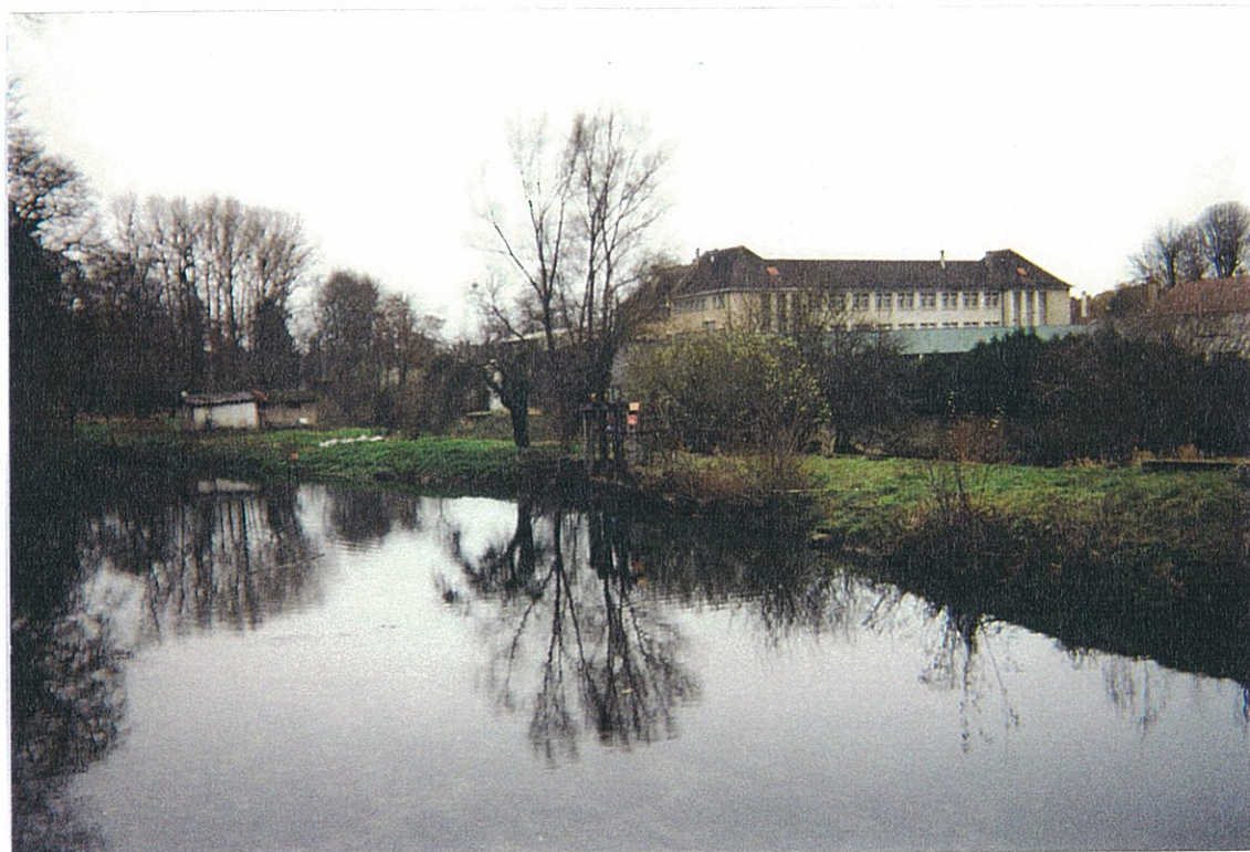
Ph.11: VANNAGE REPARTITEUR EN AMONT DU PONT RUE DE SEINE
