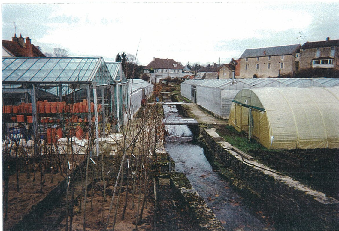
Ph.2: VUE VERS L'AVAL DEPUIS LA RD 980 BIEF D'AMENEE AU MOULIN DE FOULON
