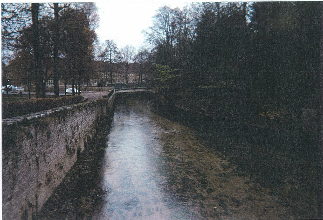
Ph.9: VUE VERS L'AVAL DEPUIS LE PONT DES BOULANGERS LA SEINE BRAS RIVE GAUCHE
