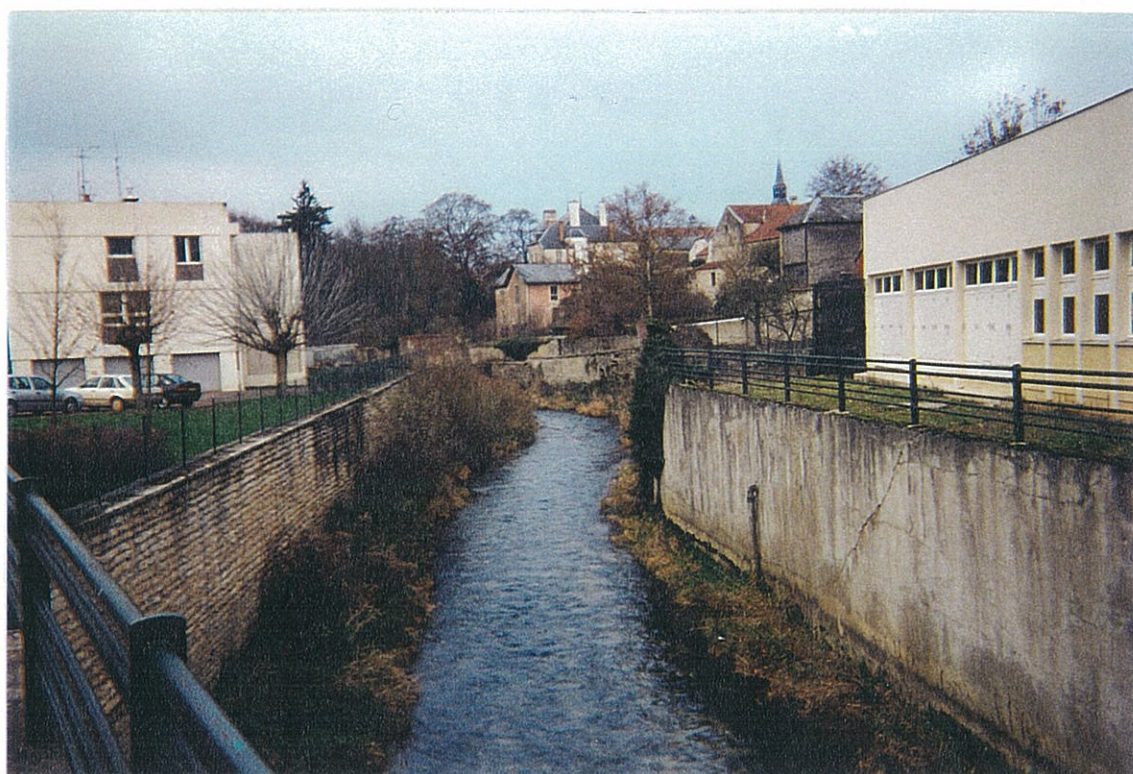
Ph.5: VUE VERS L'AMONT DEPUIS LE PONT Bd G. MORIZOT LA SEINE BRAS RIVE GAUCHE
