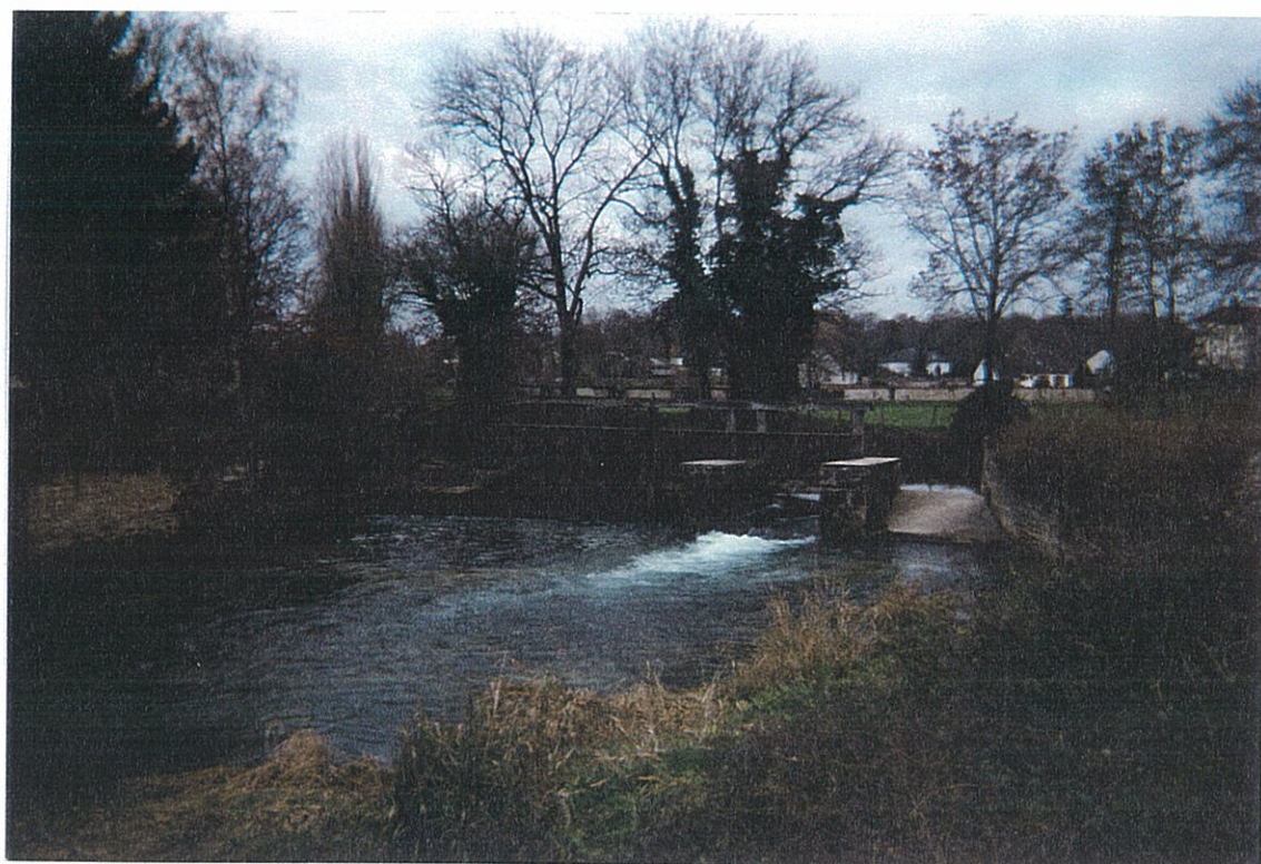
Ph. 4: OUVRAGE PARTITEUR DES EPASSES VUE VERS L'AVAL
