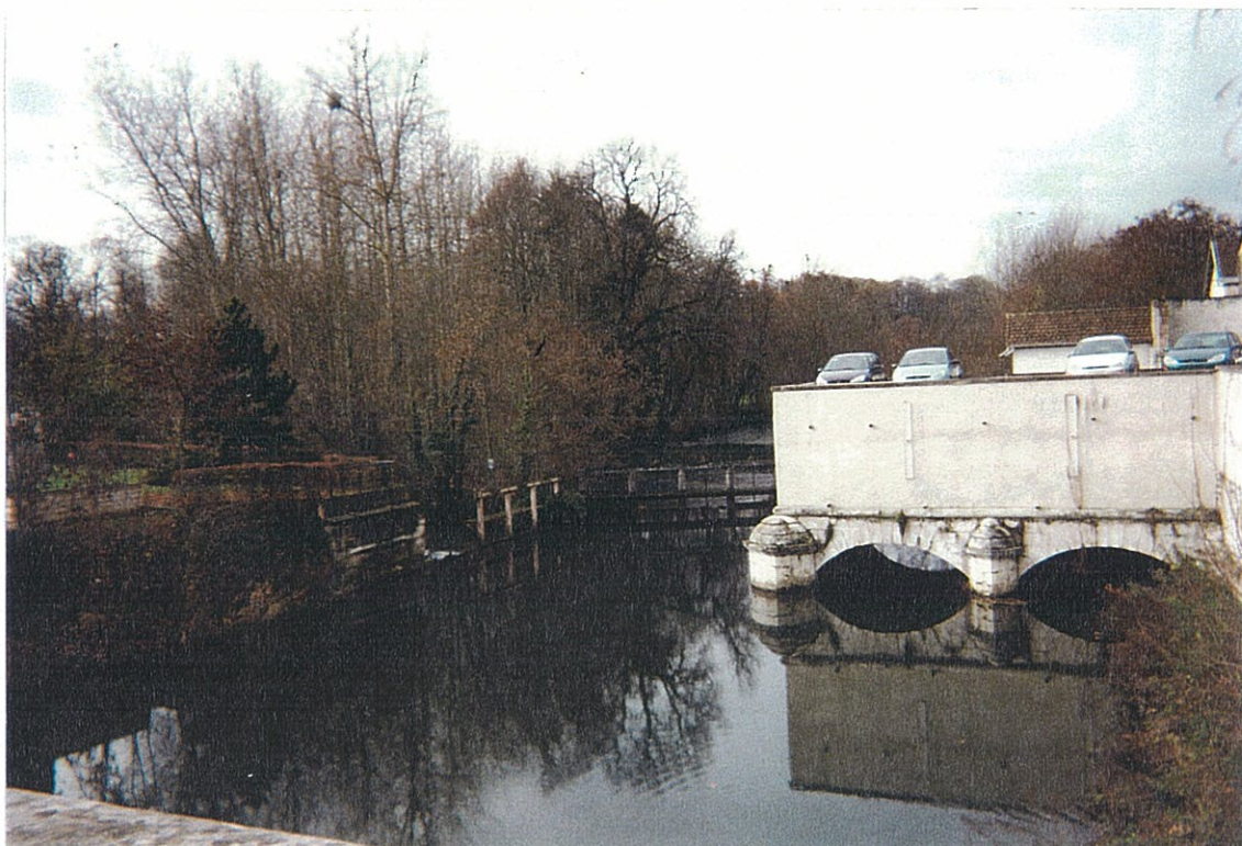
Ph.15: VUE VERS L'AVAL DEPUIS LE PONT DE LA RN 71
