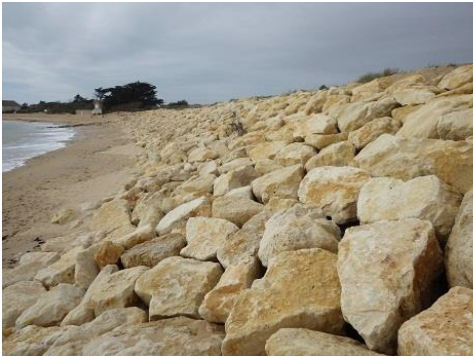
Enrochements la Perroche
