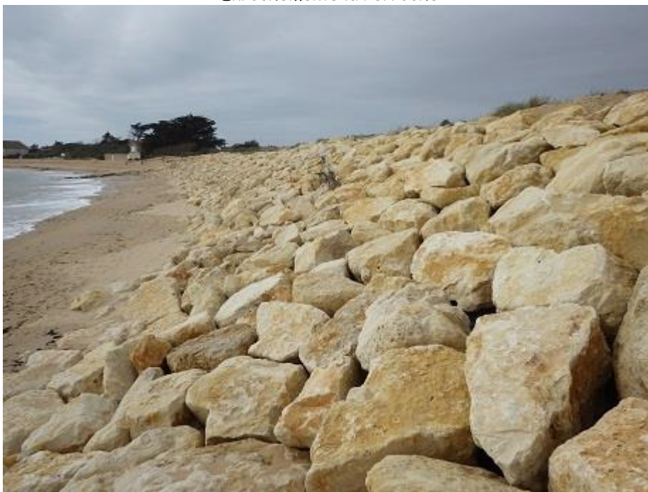
Enrochements la Perroche
