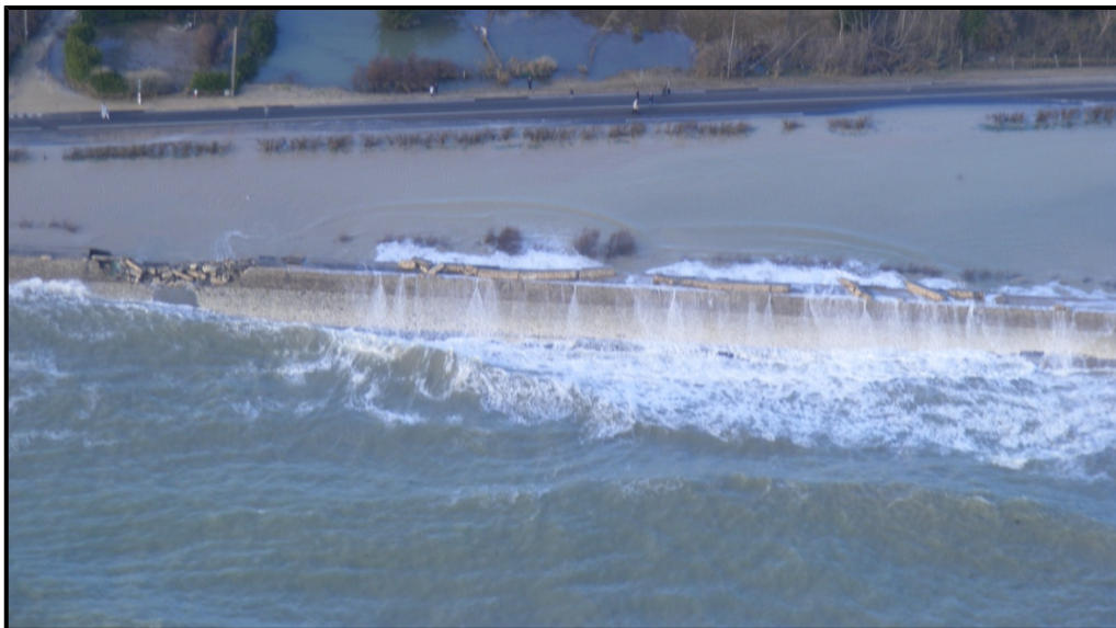
Submersion de la digue du Martray par rupture de la protection
