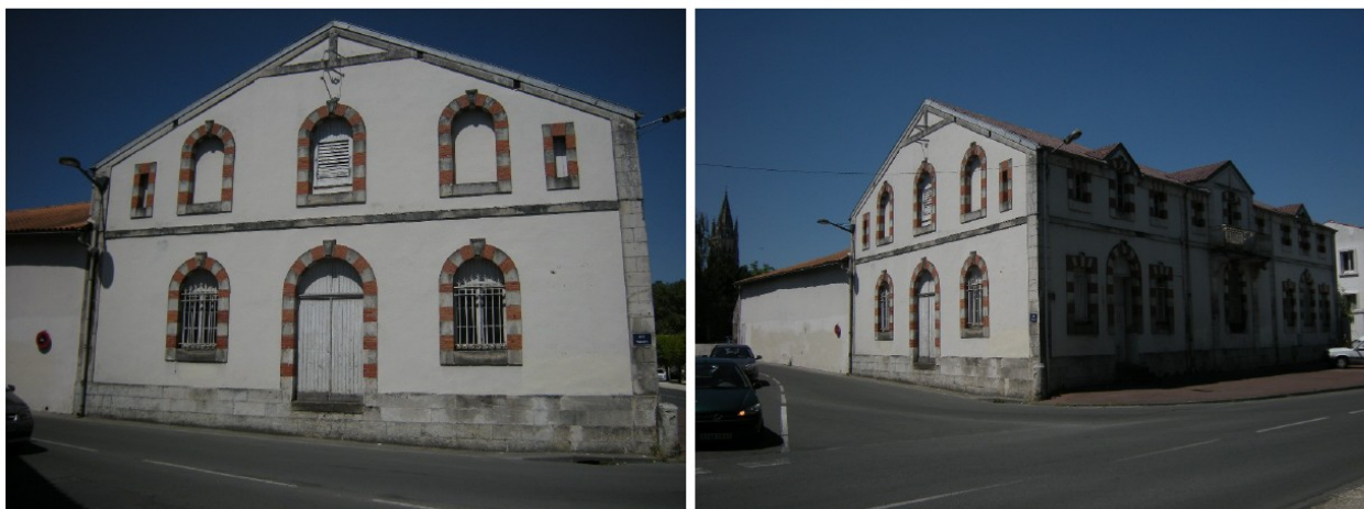
N° 2 rue Palissy (angle quai Palissy)
