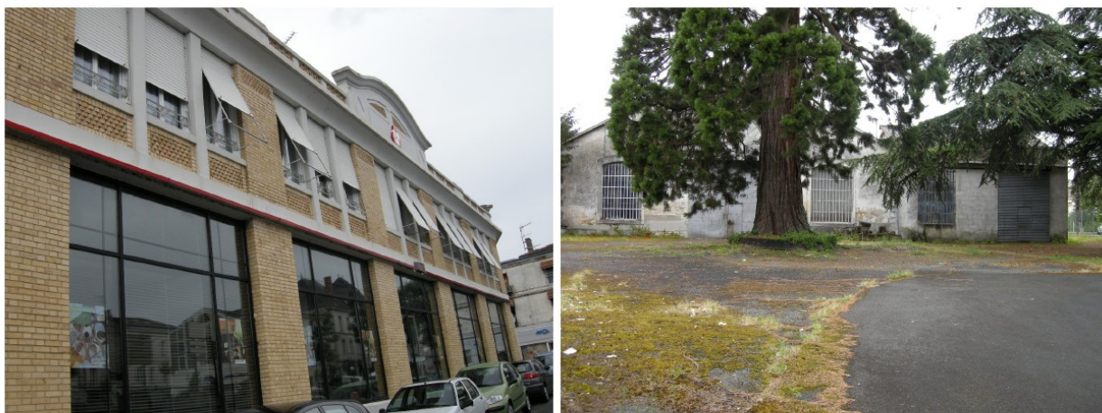
Ensemble cité Boutin – Îlot Bobrie Immeubles de qualité architecturale n°3 et 4
