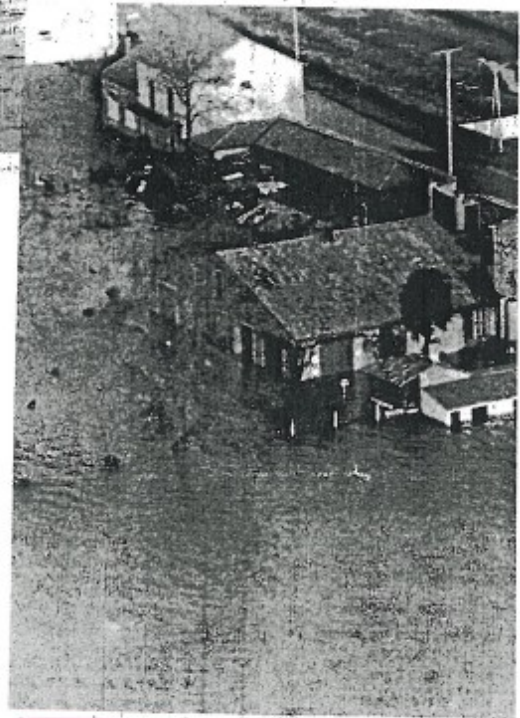
Taillebourg : tout le bas du village a été évacué; de nombreuses familles ont été hébergées au village de Cain à Saint-Savinien.
