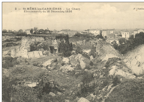
Vue de l'effondrement des Grandes Perrières en direction du village (carte postale de l'époque).
