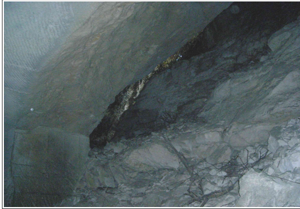
Vue souterraine de la bordure de l'effondrement Chez Troquet du 7/03/1839. La lumière du jour filtre au centre de la photo, ce qui permet d'apprécier l'important volume effondré.
