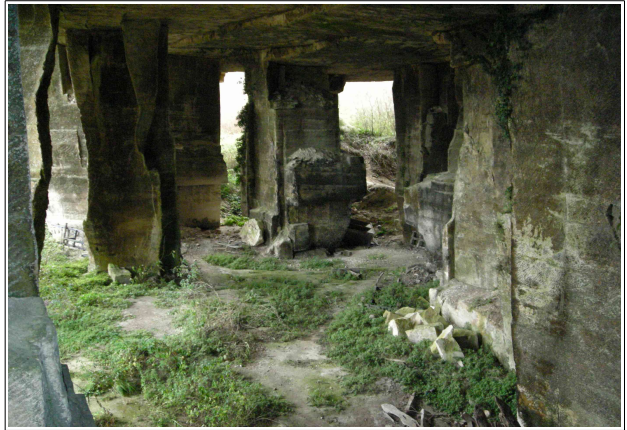
Vue du secteur des Grandes Perrières, à proximité de l'effondrement de 1837; on remarquera l'élancement des piliers et leur géométrie aléatoire probablement due à des extractions sauvages.
