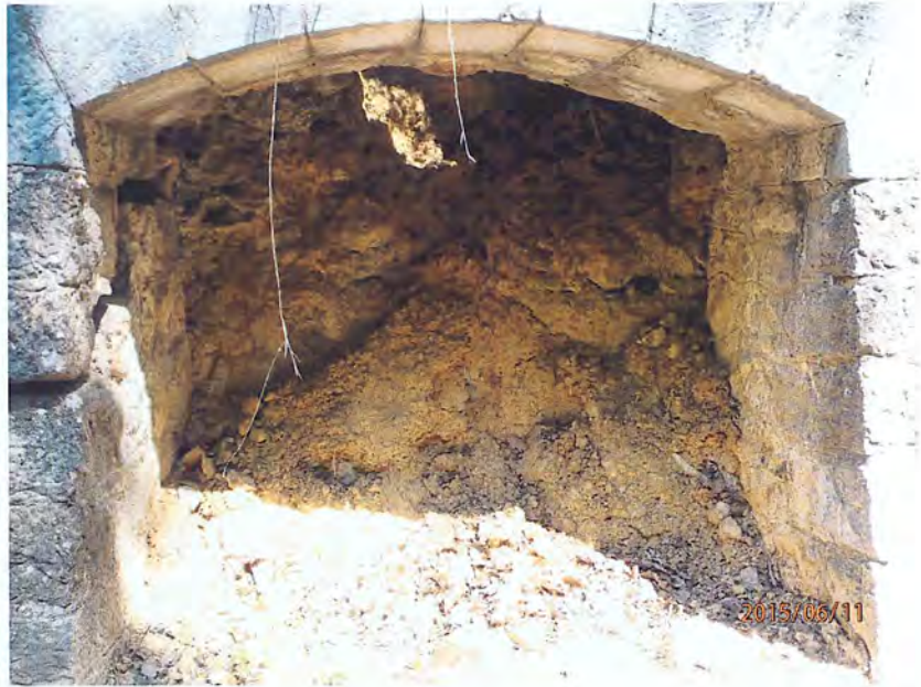
Photo n°14 : route de l'ancienne gare, à l'est du viaduc près des Valettes de Saint Antoine
