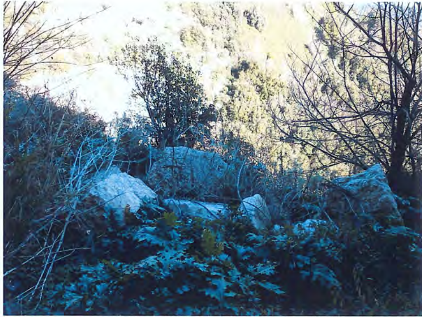
Photo n°32 : blocs effondrés en pied de falaise côté est
