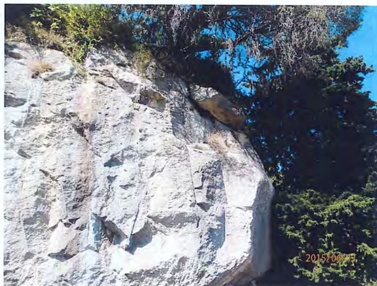
Photo n° 25 : bloc instable au-dessus de la D2210 avant le pont à la sortie du village côté ouest
