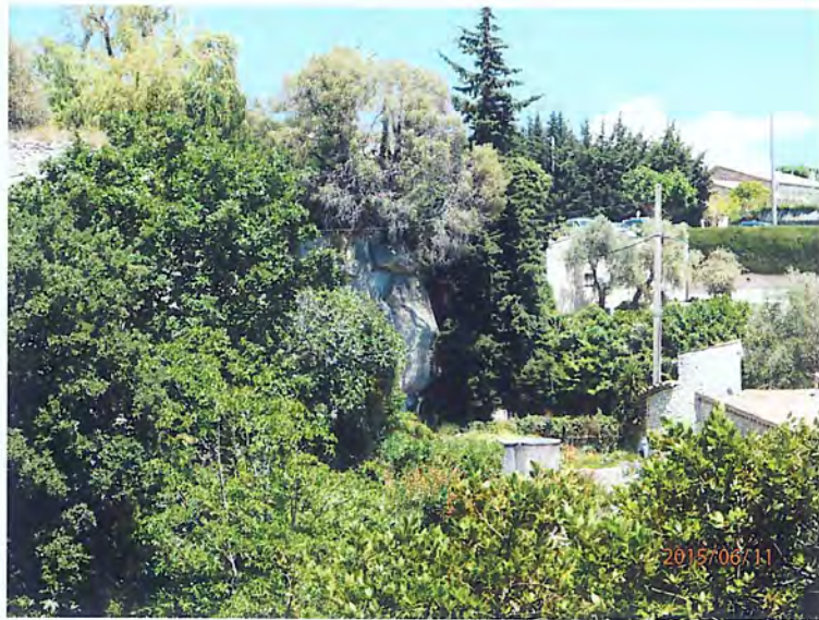
Photo n° 24 : bloc instable sous la D2210 avant le pont à la sortie du village côté ouest
