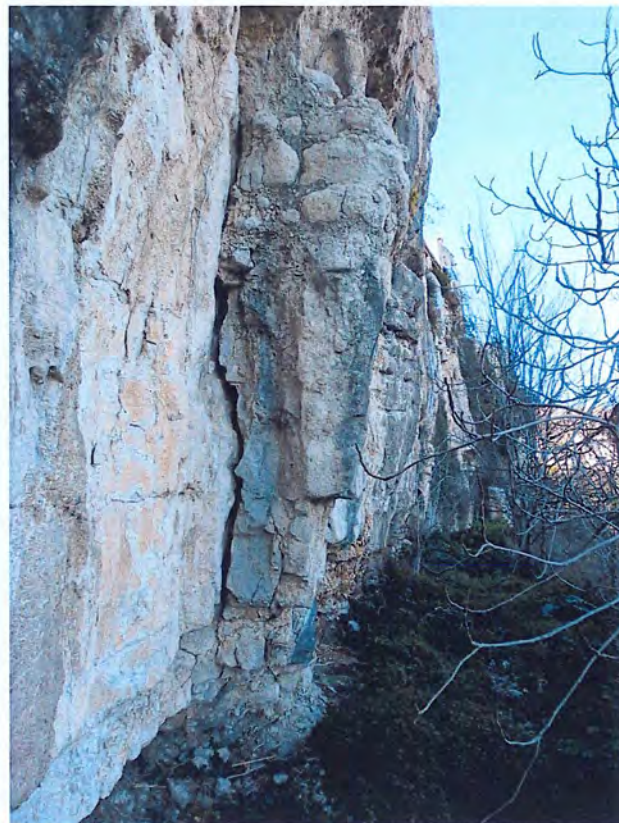
Photo n°29 : écaille se détachant de la falaise côté est
