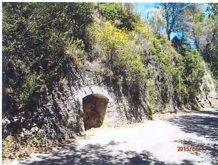
Photo n°43 : murs en pierres le long de l'ancienne voie ferrée
