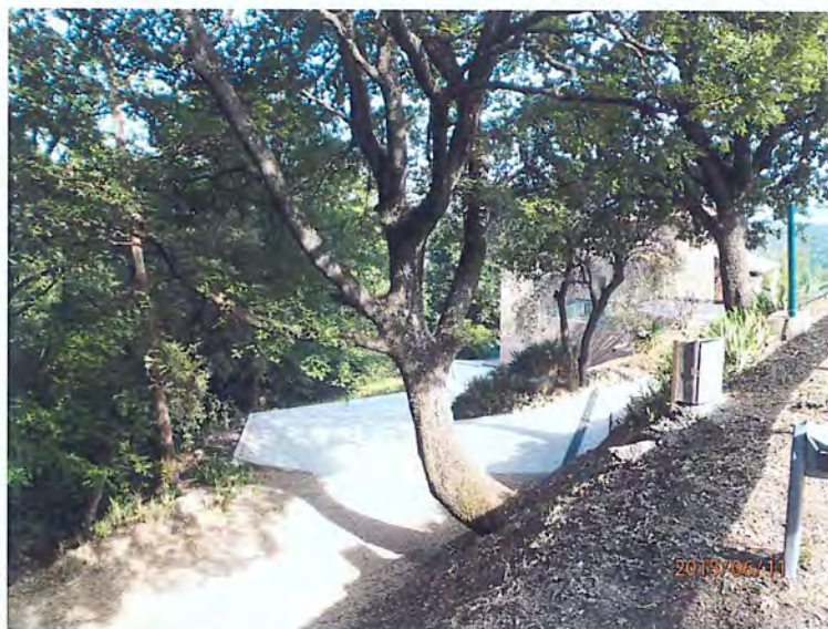
Photo n°12 : Quartier du Ray Habitation vue du sommet de la falaise – Parcelles E315 et 2313
