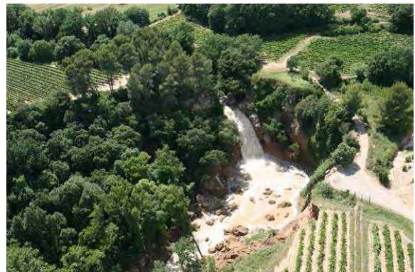
Photos 124 : Saut du Capellan - Vue post crue
