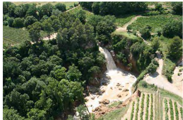
Photos 124 : Saut du Capellan - Vue post crue
