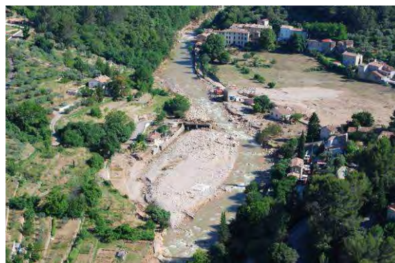
Photos 67 : La Nartuby à Rebouillon – Post Crue
