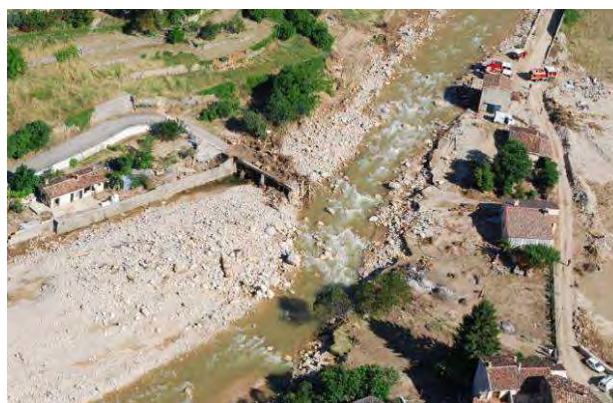
Photos 69 : La Nartuby à Rebouillon – Post Crue
