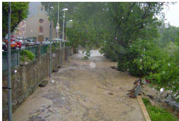
Photos 112 : Trans en Provence centre – Post Crue
