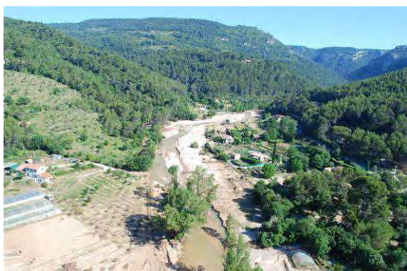
Photos 70 : La Nartuby secteur Granegone – Post Crue
