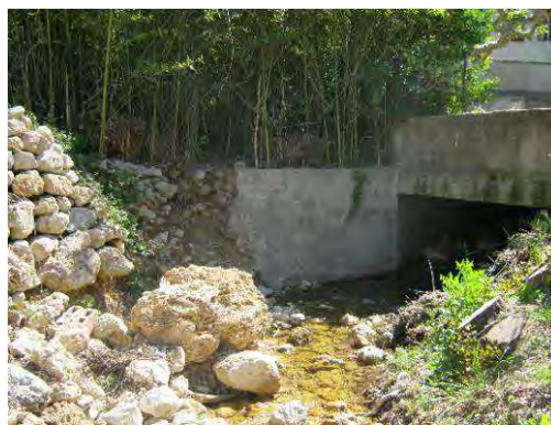
Photos 138 : Figanières – La Tuilière – entrée du passage couvert obstruée et insuffisante en juin 2010
