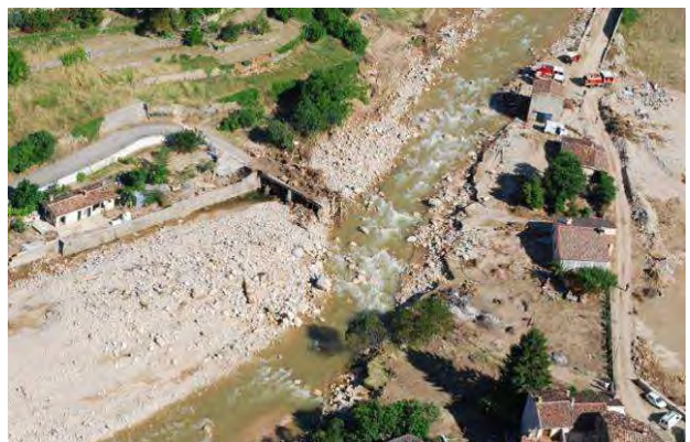
Photos 69 : La Nartuby à Rebouillon – Post Crue
