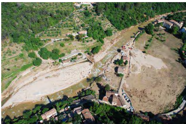
Photos 68 : La Nartuby à Rebouillon – Post Crue
