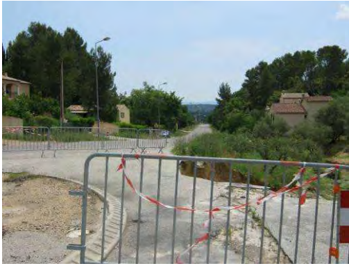
Photos 30 : Le Réal Calamar à Lorgues - Post crue
