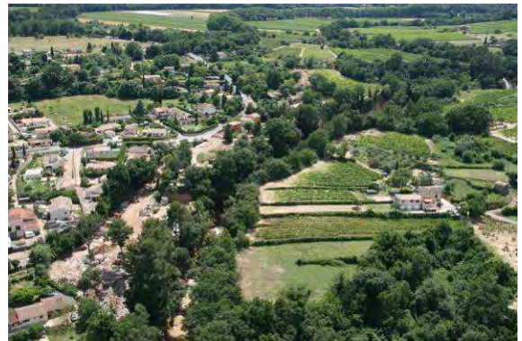
Photos 120 : Au droit de « entre deux Eaux » retour des eaux débordées dans le Nartuby
