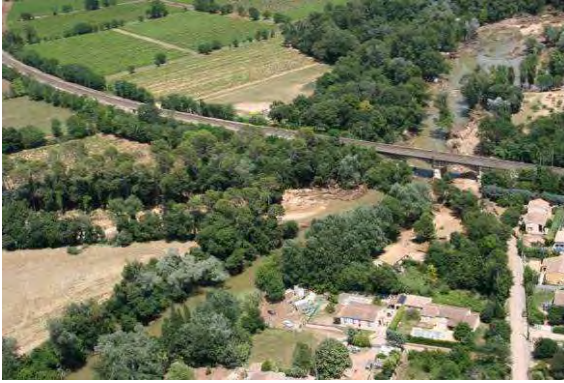
Photos 6 : L'Argens à la confluence avec la Florièze – Vidauban (photo post crue)
