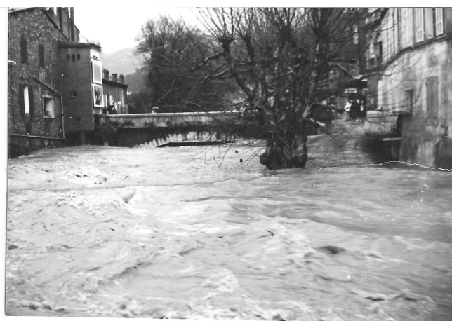
Figure 10 : Crue du 17/11/1978 au pont neu à Roquevaire (source communale)
