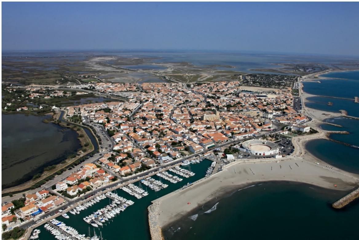
Système de protection au droit du centre-ville : digue à la Mer, épis et brise-lames
