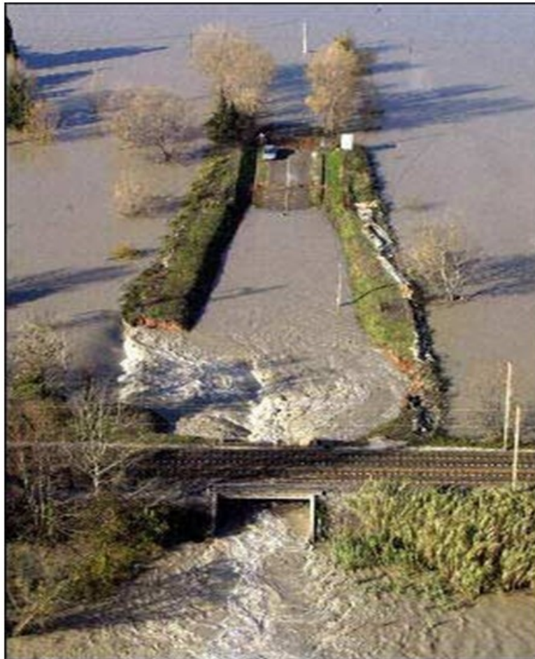
Rupture des cavaliers de protection de la trémie en 2003
