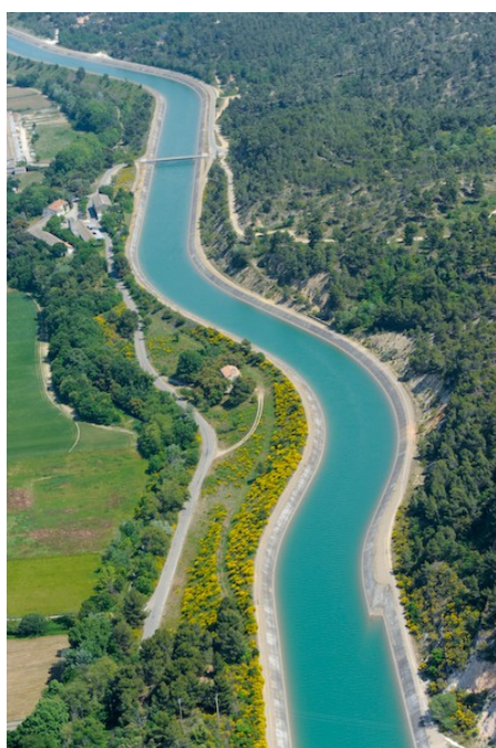
Photos du canal EDF
