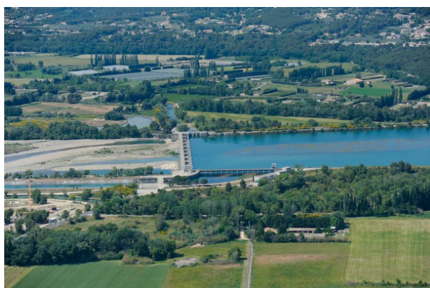
Barrage de Mallemort
