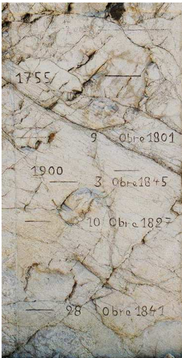
Figure 6 : Repères de crue à Avignon
