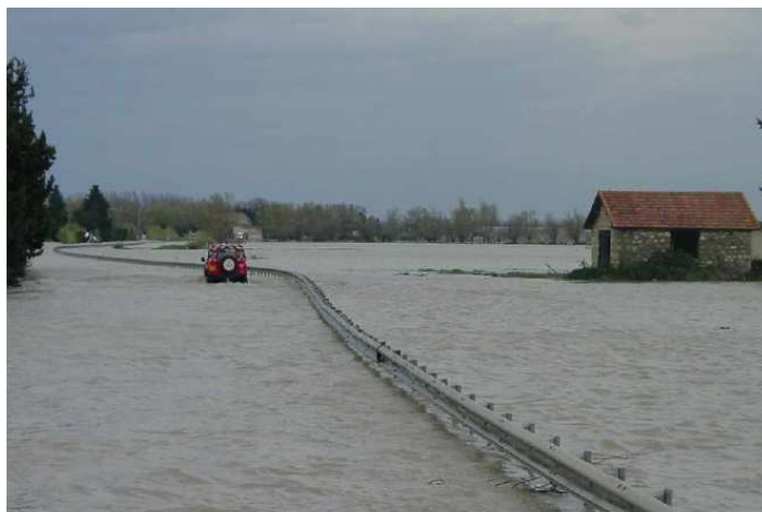
Figure 7 : Route de Tarascon à Arles le 4 décembre 2003
