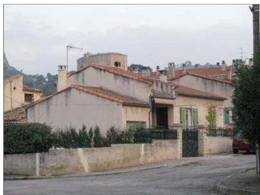
Photo. 6: Exemple de bâtiments de la typologie « Lotissement »
