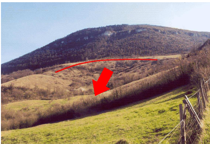
ancien grand glissement affecté par des mouvements secondaires (les Combes-Hautes, Millau)
