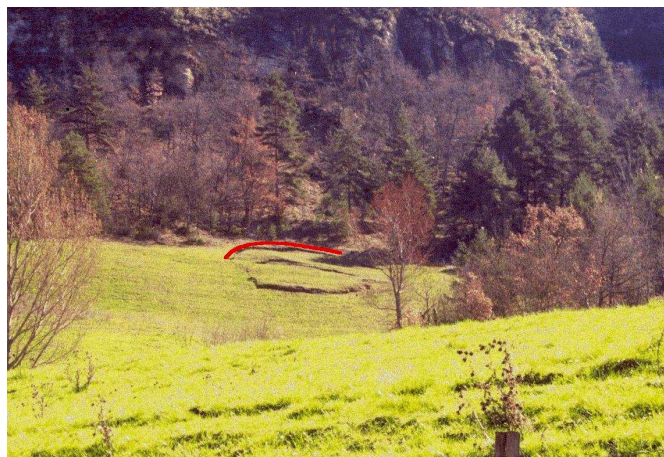
glissement plan - plaque glissée nettement visible (Lausset Basse, La Cresse)
