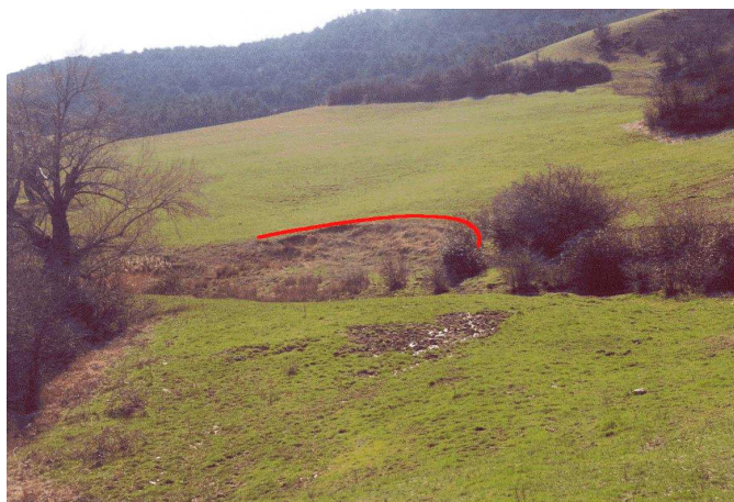
loupe de glissement récente (Luganac, Compeyre)
