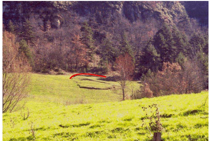
glissement plan - plaque glissée nettement visible (Lausset Basse, La Cresse)
