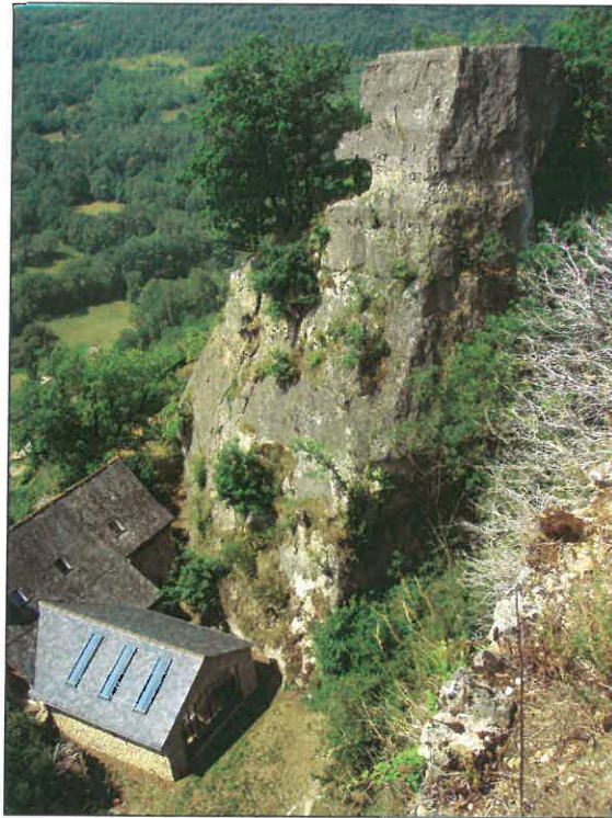
Secteur de Saint-Laurent Maisons adossées à des falaises massives
