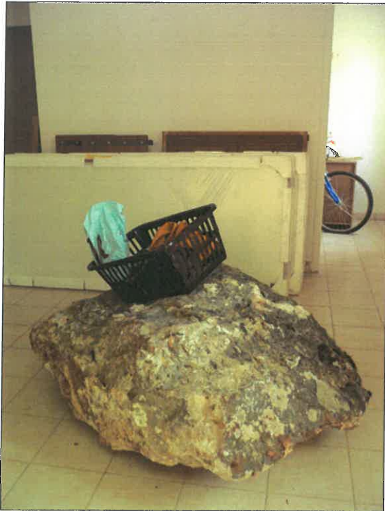
Village de Salles-la-Source - Secteur du cimetière Bloc ayant atteint l'annexe de la maison (août 2007)
