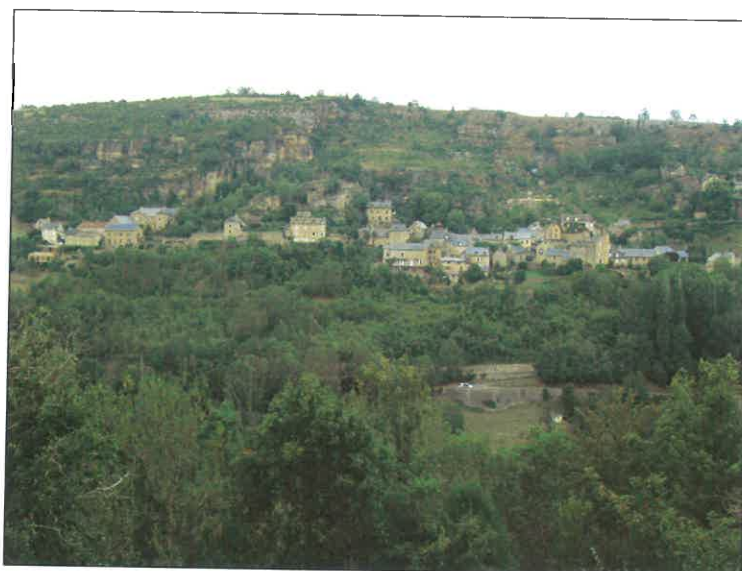
Versant sous la voie ferrée, en face du village de Salles-la-Source Glissement supposé
