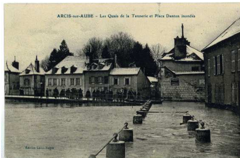
Crue de 1910 à Arcis-sur-Aube– Les quais de la Tannerie et la Place Danton inondés
