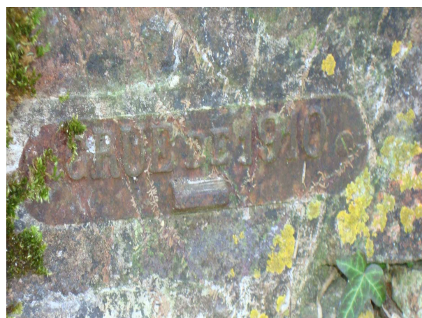
Repère de crue de 1910 (situé sur la culée de l'ouvrage)
