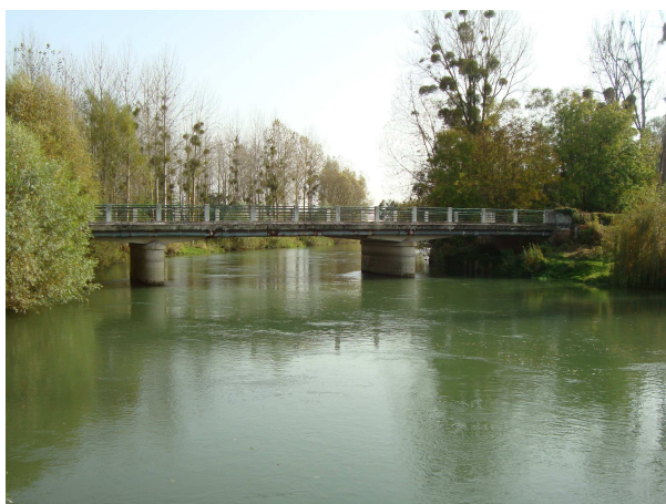
Pont de la route départementale n°134
