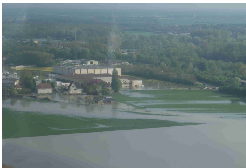
Figure 5 : Inondations en mai 2013
