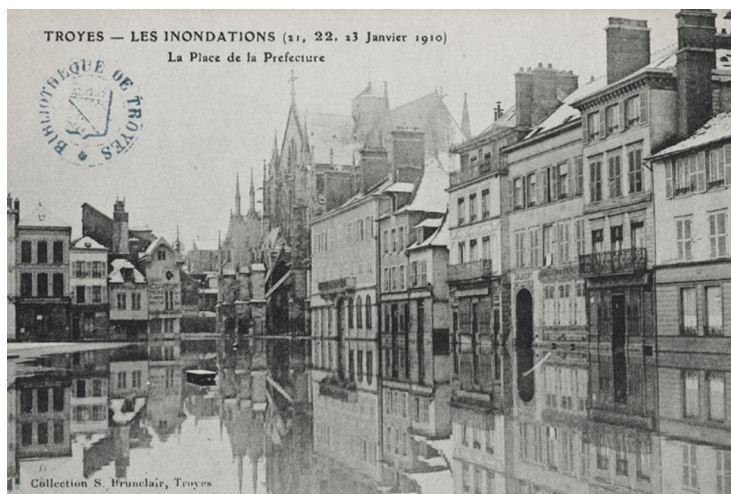
Figure 4 : Inondation de Troyes en janvier 1910
