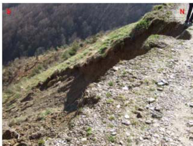
Figure 6. Glissement dans le thalweg au-dessus des granges de Ségura, dont l'origine est une sortie d'eau canalisée, et qui a eu pour conséquences le glissement d'une partie du chemin D703.
