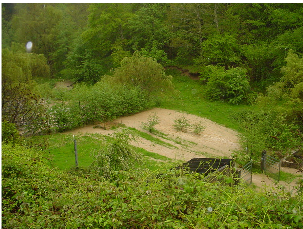
9 Mai 2002 : Propriété anciennement Huertas Eaux franchissant la digue du bassin inférieur (maison évacuée par SDIS) Clichés Jacques BLANC - Service RTM09-31
