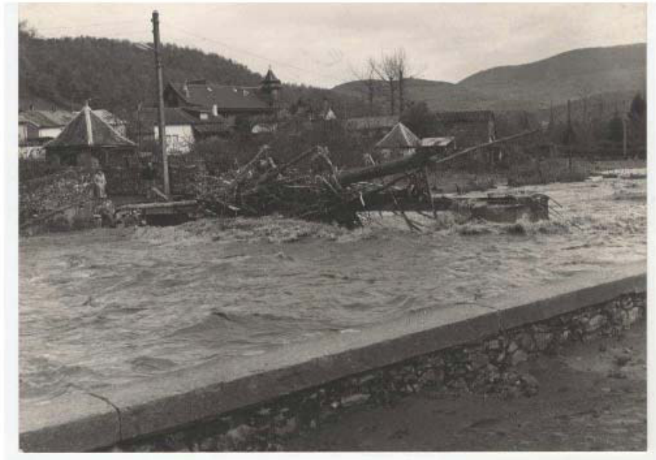
Figure 23. Crue du Salat du 7 novembre 1982. Le Salat a emporté la passerelle, et la boue au premier plan est due à un débordement latéral en amont. Un embâcle s'est créé au niveau des piles de la passerelle. (Photo de Mme Sorine, habitante de Seix)
