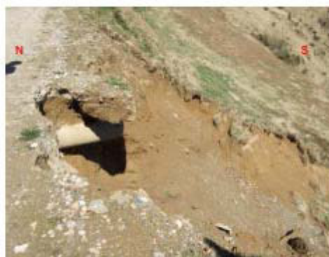
Figure 6. Glissement dans le thalweg au-dessus des granges de Ségura, dont l'origine est une sortie d'eau canalisée, et qui a eu pour conséquences le glissement d'une partie du chemin D703.
