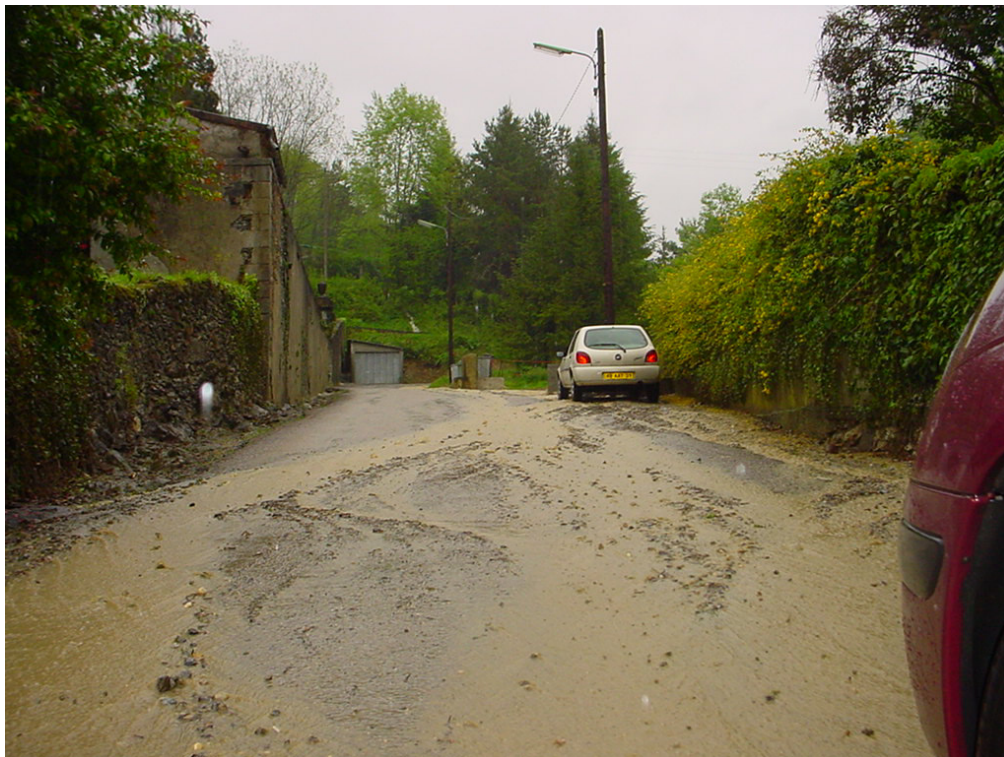
Précipitations du 9 Mai 2002 : Rue du Cimetière - Débordement des bassins chez Ancinnt Huertas (Aqueduc bouchés) avec ruissellements sur la route. Clichés Jacques BLANC - Service RTM09-31
