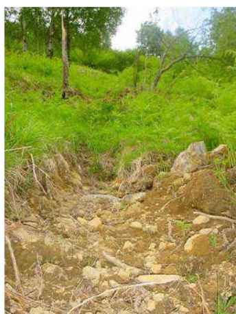
Alt 1000m, Tranchée ouverte par la chute d'un bloc sur l'extension Nord de la zone touchée
