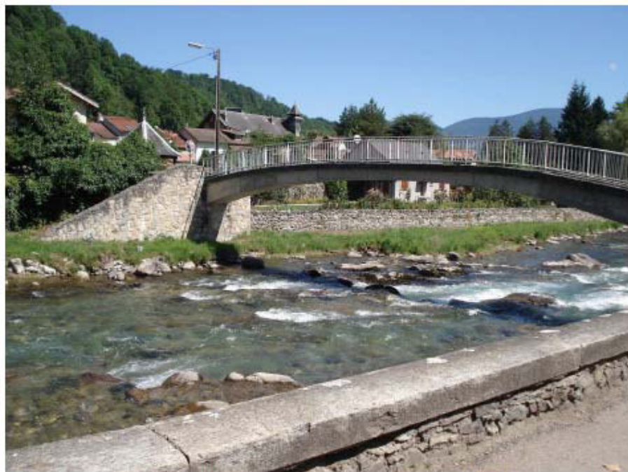
Figure 24. Le Salat en juin 2009, pour comparaison. A noter l'architecture de la nouvelle passerelle, sans appui dans le lit de la rivière pour éviter les embâcles. Photo de J. Blanc, service RTM.
