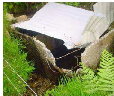
Bassin endommagé par les chutes de blocs
