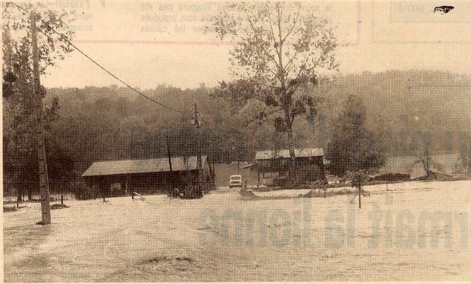
Après la décrue... les dégâts.
