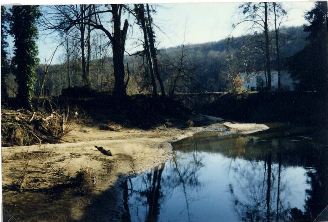
Photos : Erosions de berges suite à la crue du Volp du 24/09/1993 (Source RTM)
