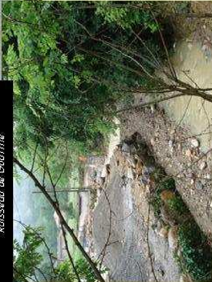
Engrèvement de l'ouvrage de franchissement de la RD et du lit du ruisseau
