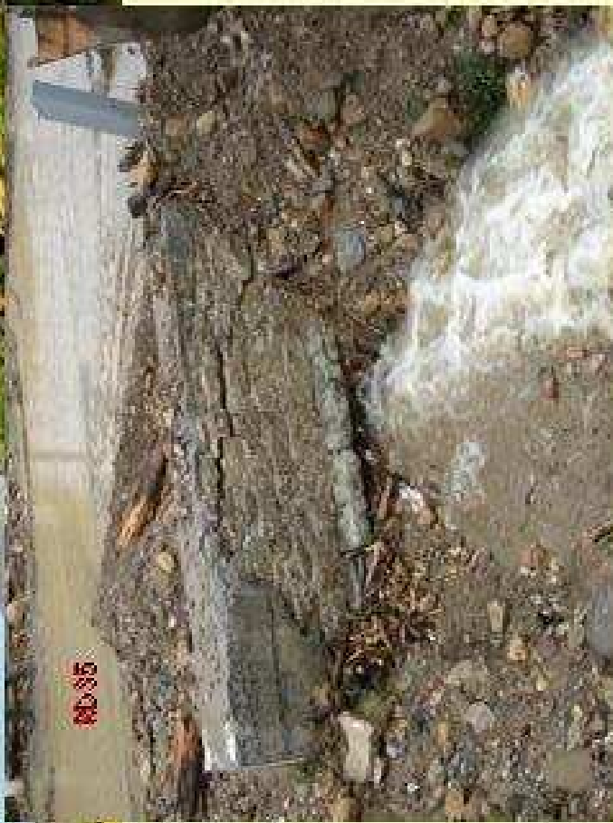
Engrèvement de l'ouvrage de franchissement de la RD et du lit du ruisseau
