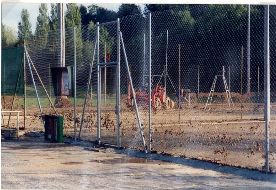
Photos : Traces de la crue du Volp du 24/09/1993 (Source RTM)
